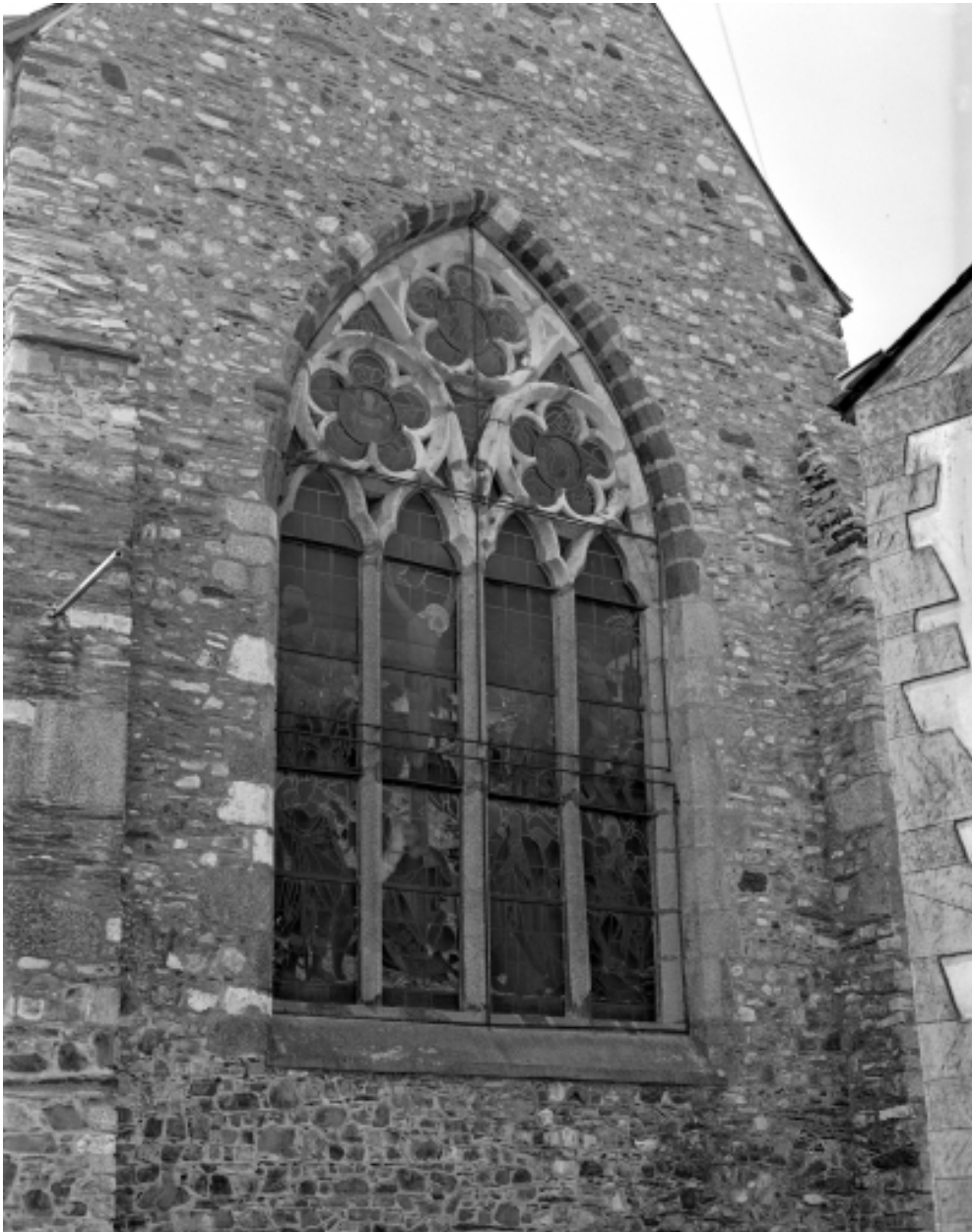
Elévation est, baie : vue générale
