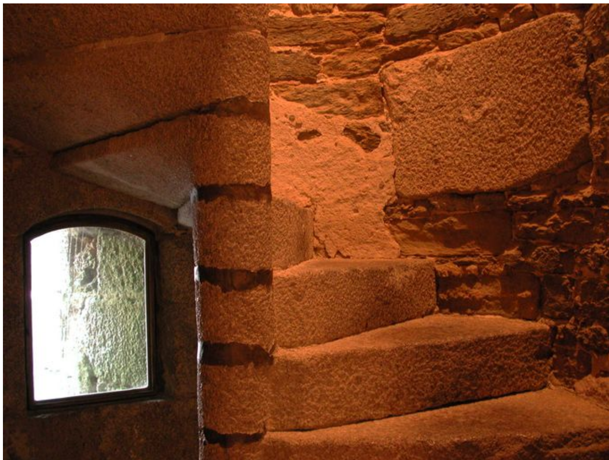
Vue de l'escalier à vis desservant les parties hautes et logé dans le saillant arrière
