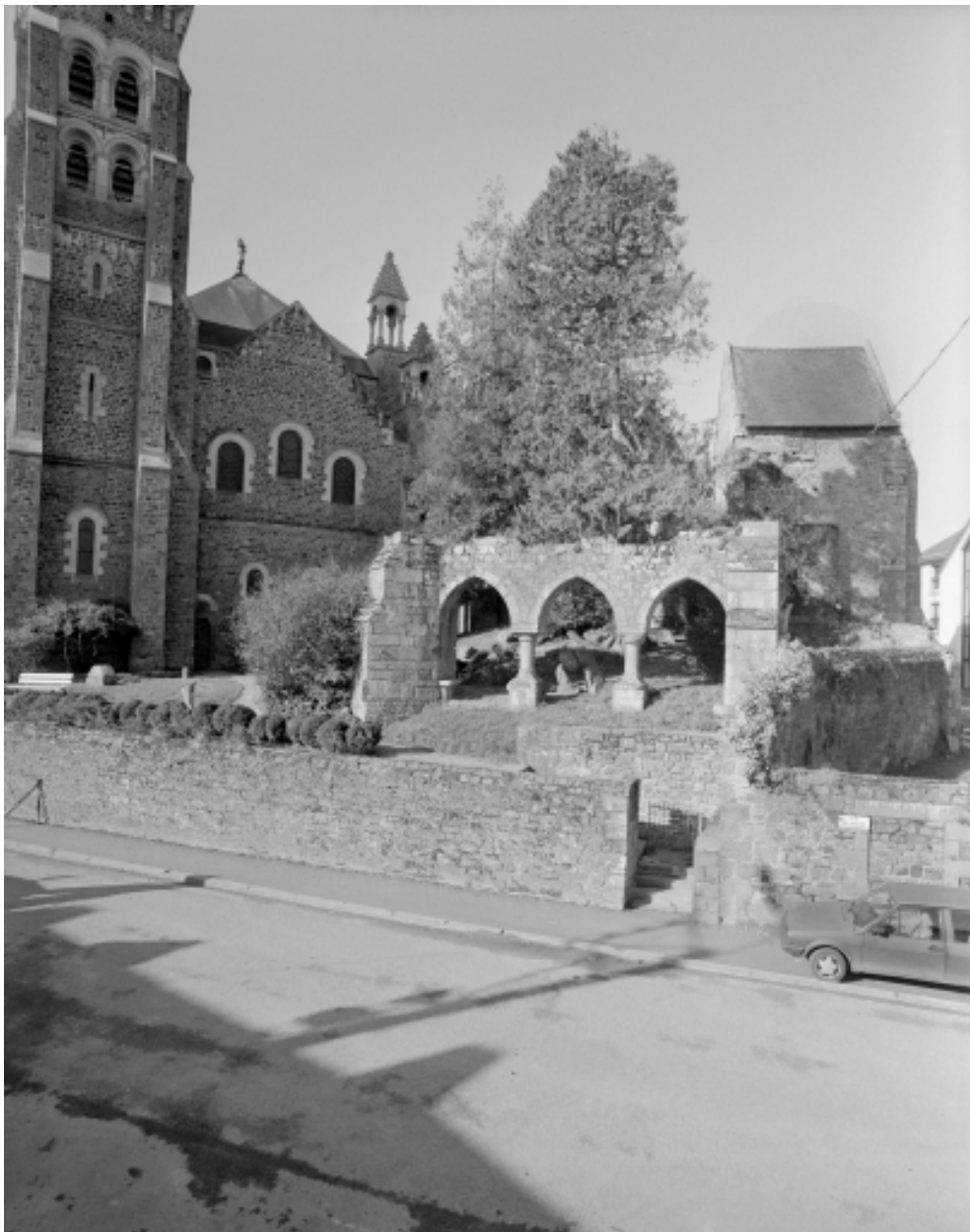
Elévation nord-est et vestiges de l'ancienne église
