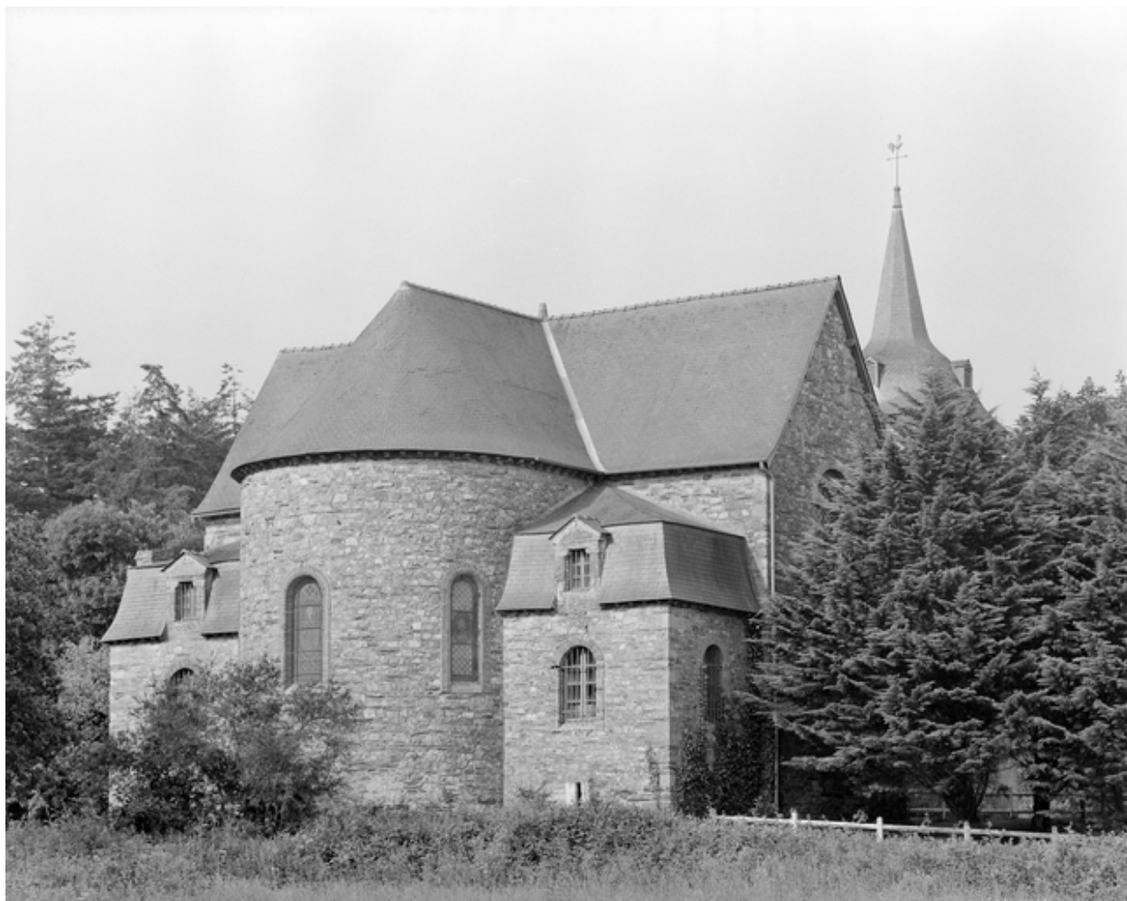
Vue de situation nord-est
