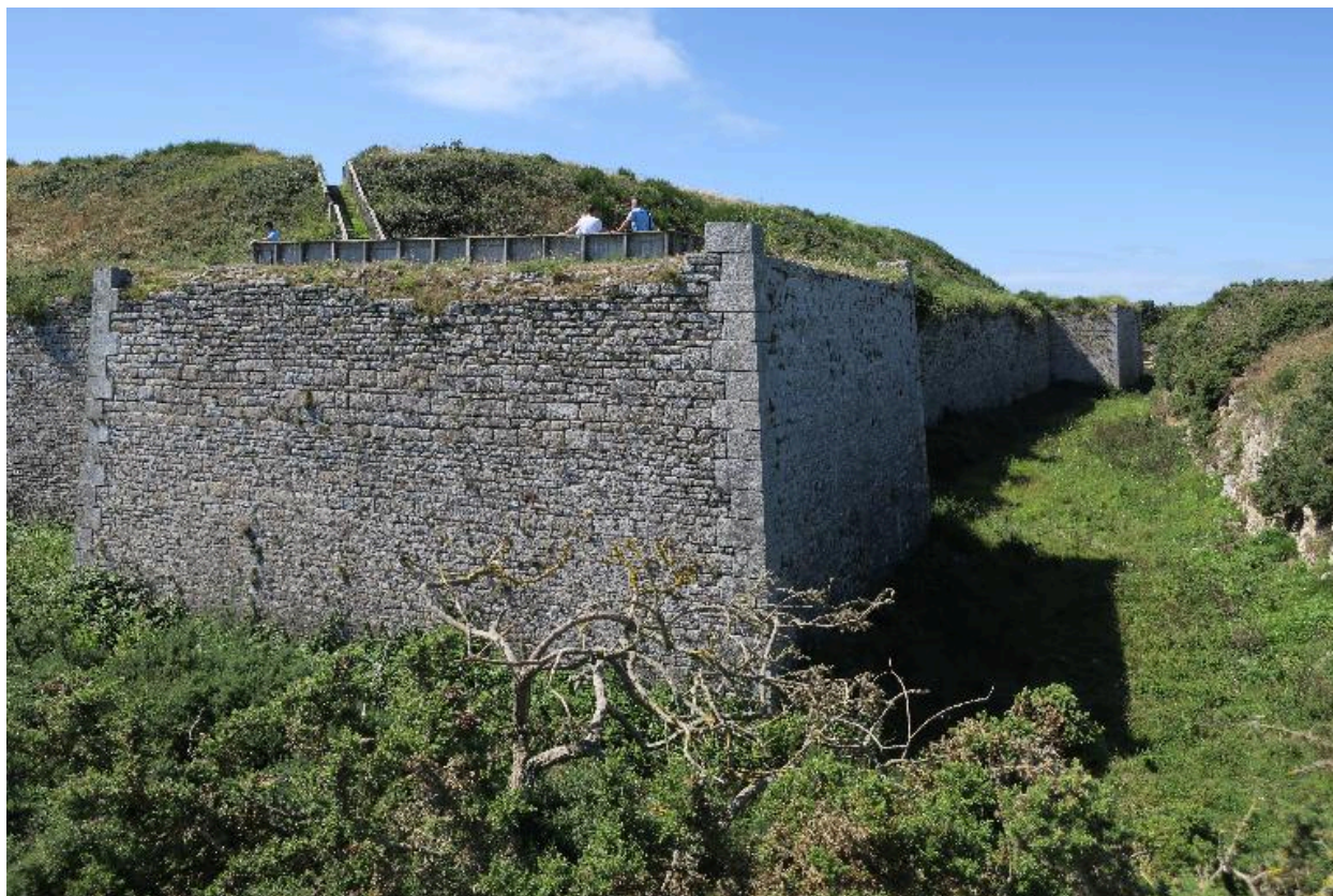
Hœdic, fort central, saillant sud-est.
