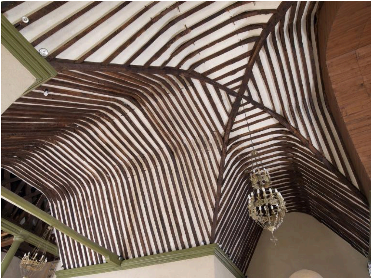
Eglise Saint-Melaine, vue intérieure de la charpente de la nef et de la croisée du transept
