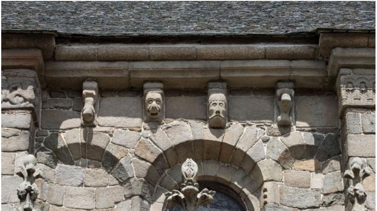
Mur sud de la nef : détail des modillons de la corniche
