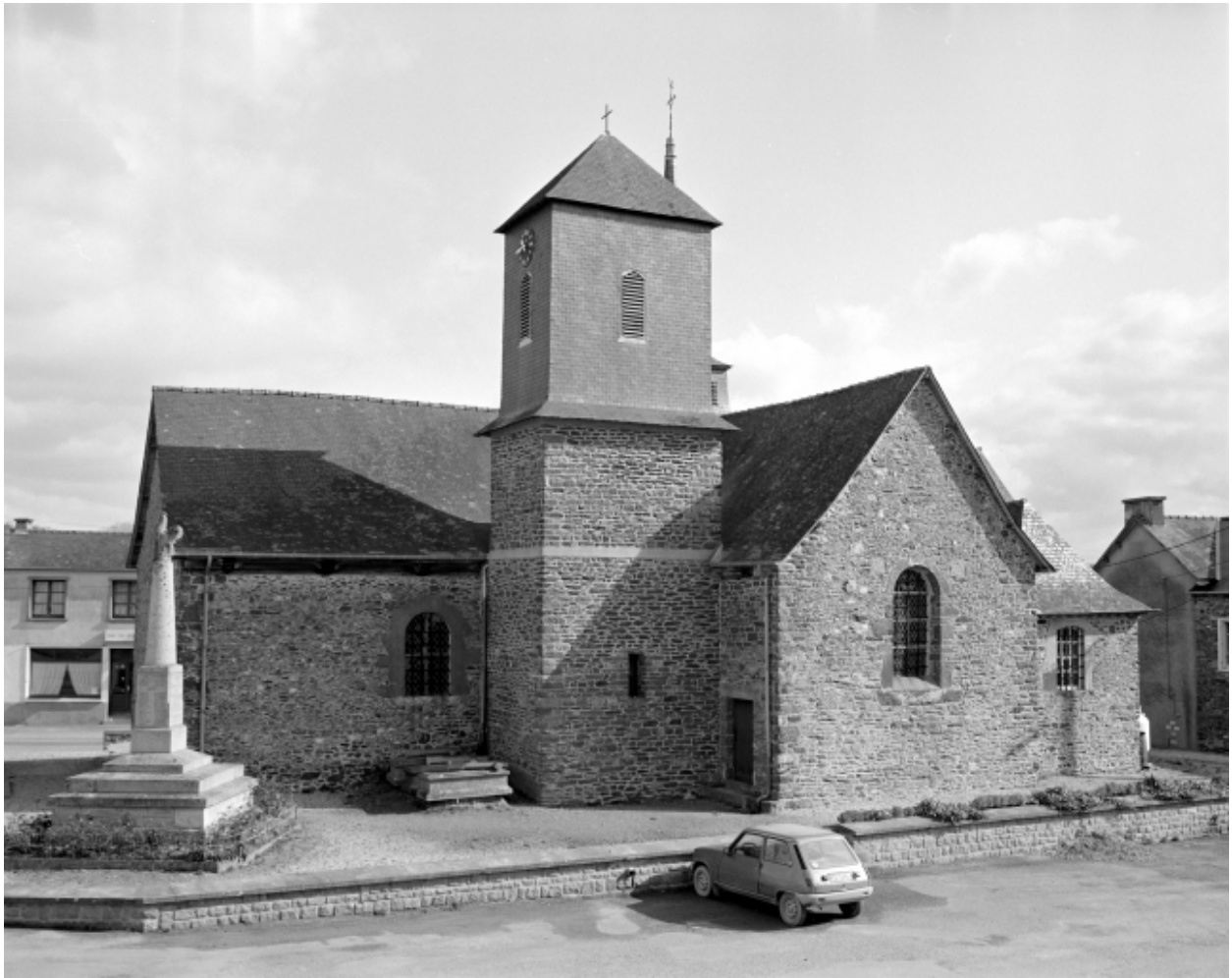
Elévation Sud : vue générale
