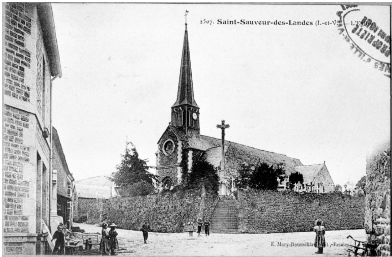
Élévation Sud-Ouest : vue générale (Carte postale ancienne)
