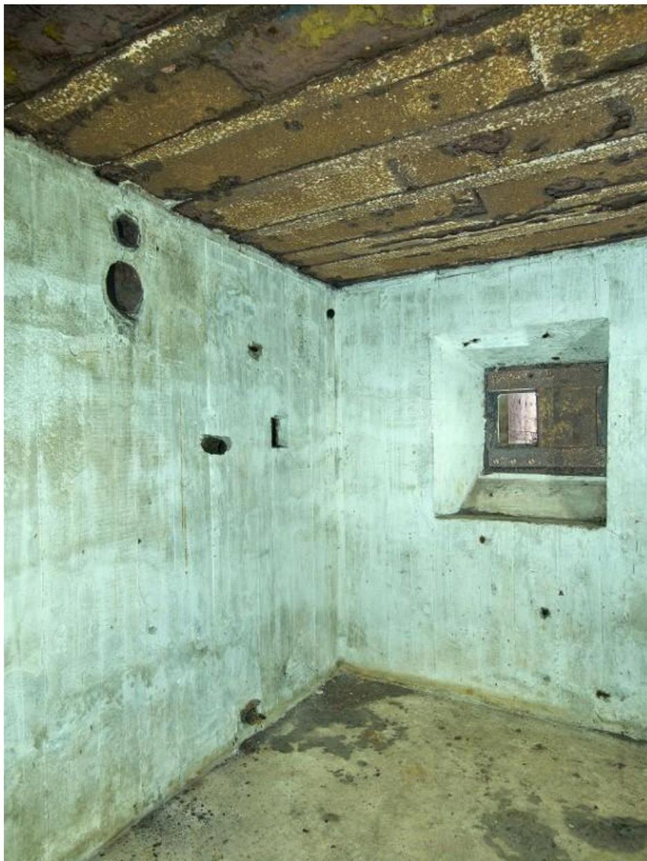
Vue de la salle de garde nord, créneau blindé défendant l'entrée nord. A droite, en haut, conduites du poêle. Dans l'angle se trouve un tube acoustique communiquant avec le poste d'observation extérieur
