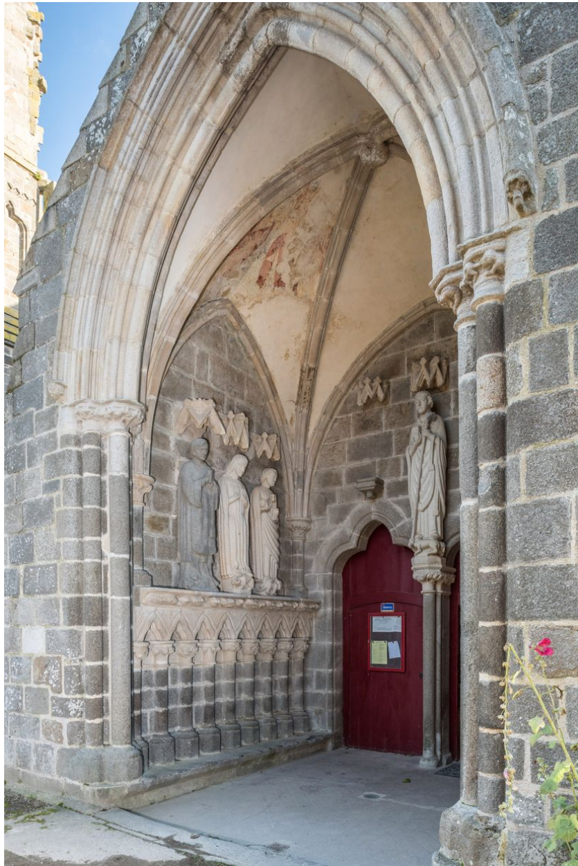
Le porche nord, vue générale
