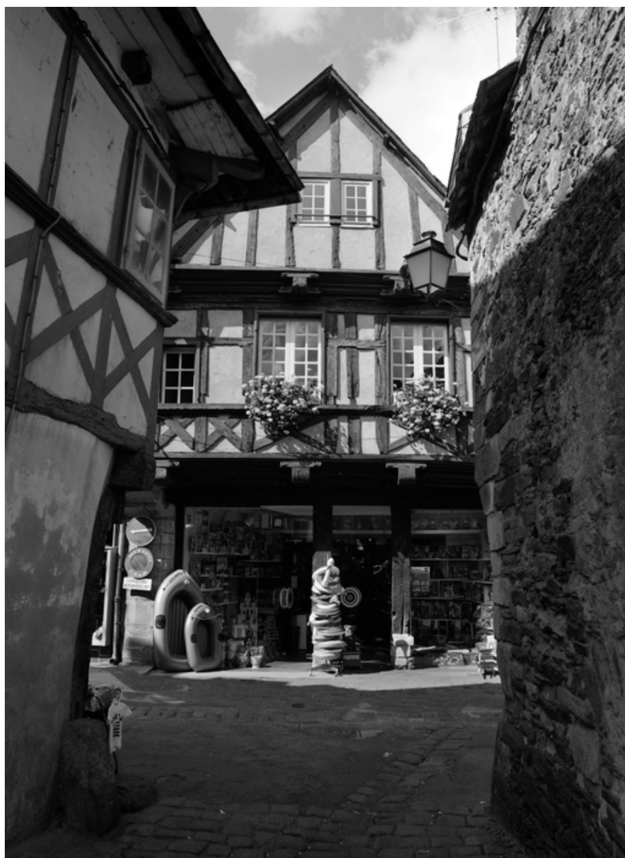
Vue générale de la façade.
