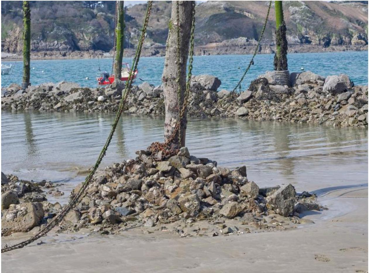
Détail des enrochements au pied des troncs d'arbre formant mouillage.
