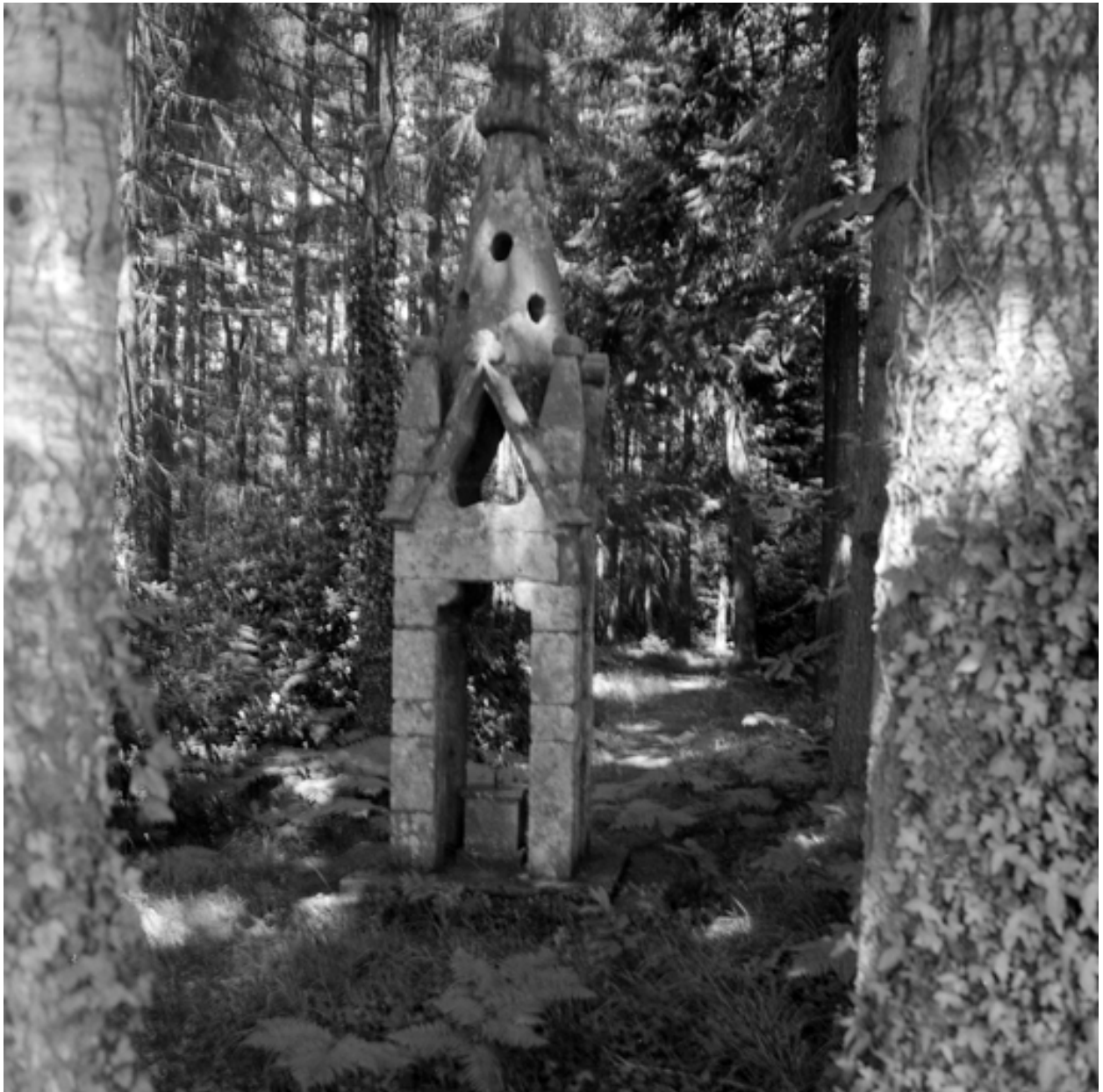
Chapelle, vue générale du clocher isolé.
