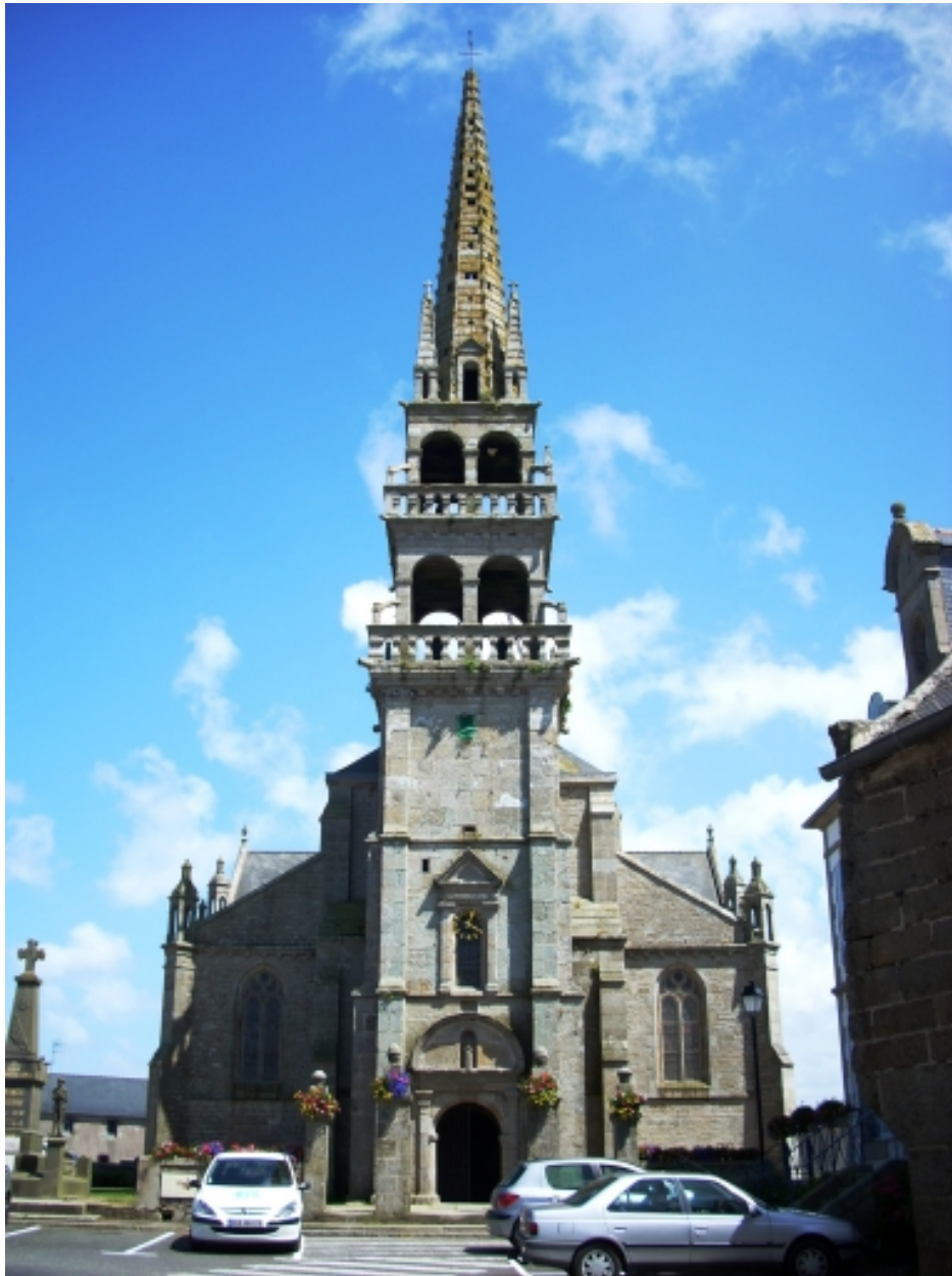
Plounéour-Trez, église paroissiale : élévation ouest
