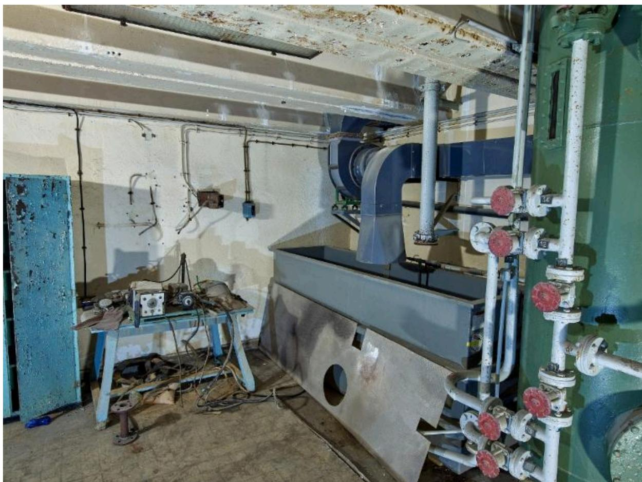
Vue de l'un des deux bacs en résine polyester avec hotte d'aspiration et système de tuyauterie. A gauche, armoire d'atelier et établi. Le plafond est constitué de poutres préfabriquées en béton armé avec avec plafonnier à lampe fluorescente
