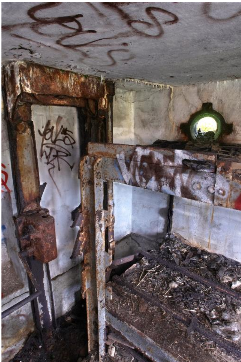
Vue intérieure de l'un des magasins de combat : étagère et monte-obus avec treuil manuel dans un compartiment à projectiles (état en 2009)
