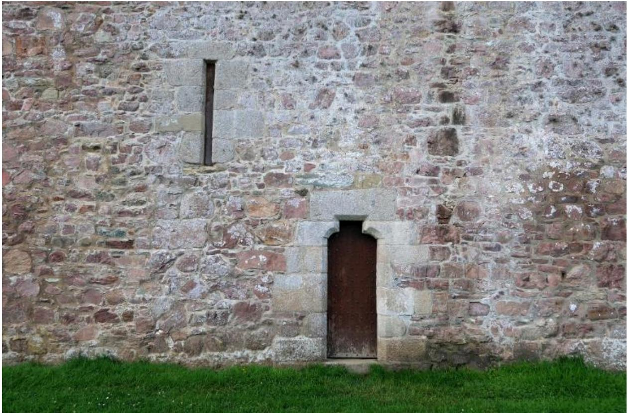
Vue de l'élévation postérieure côté Trieux : détail de la poterne (linteau droit sur coussinets en pierre de taille de granite). Le grand jour vertical éclaire l'escalier en vis sud. La maçonnerie est en en moellon de grès rose ou rougeâtre
