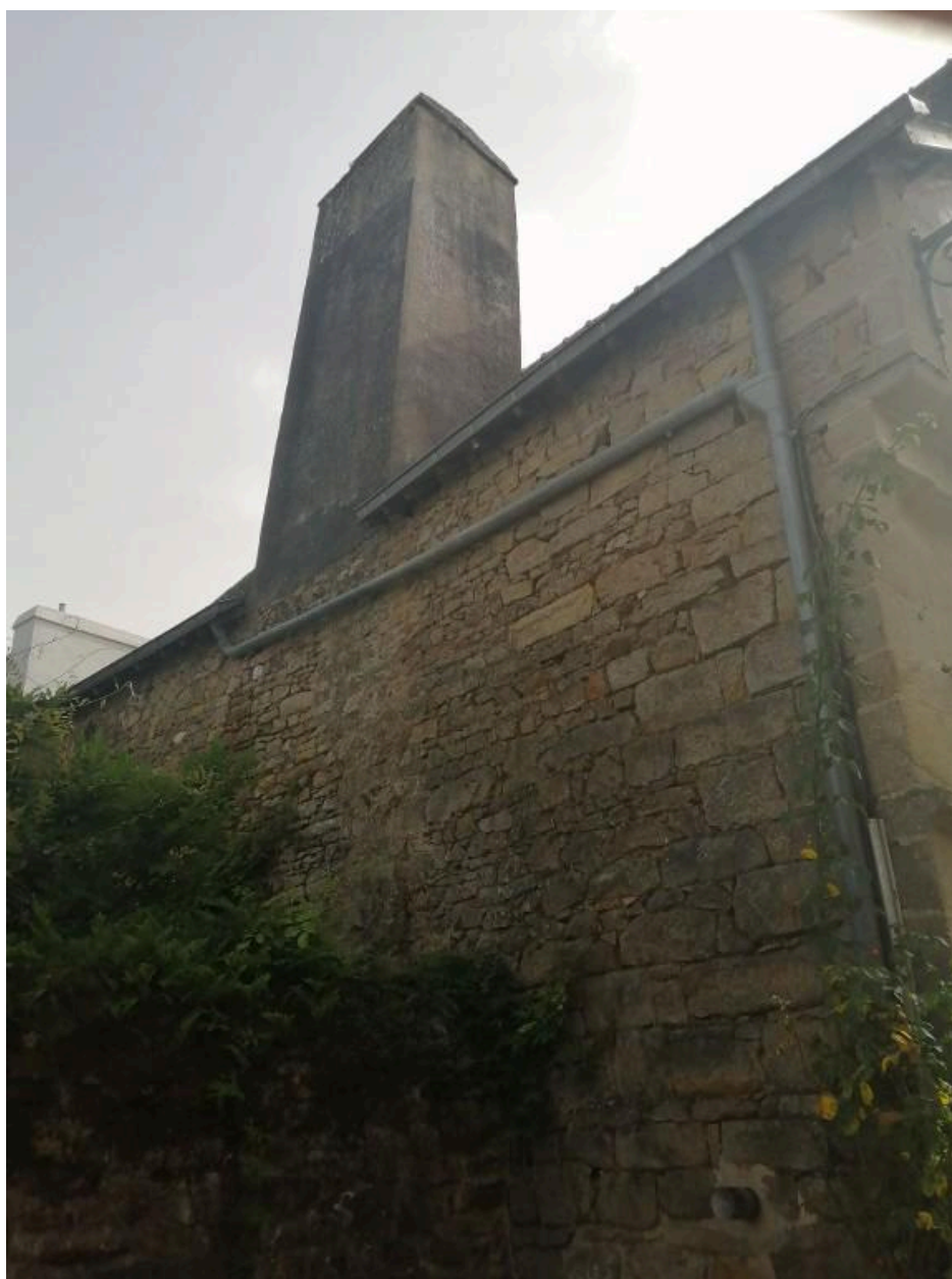
Détail du mur gouttereau en pierre et de la cheminée enduite en ciment
