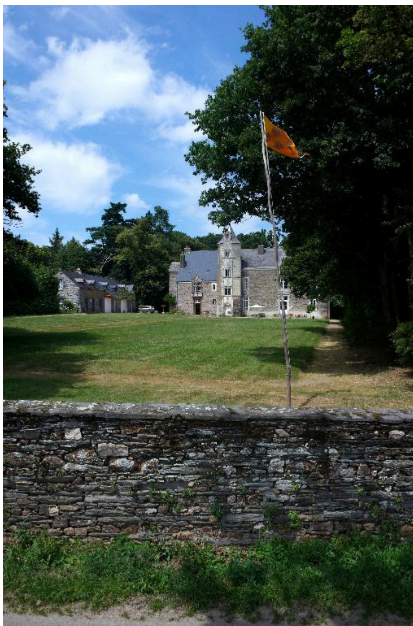
Vue générale : vue du sud
