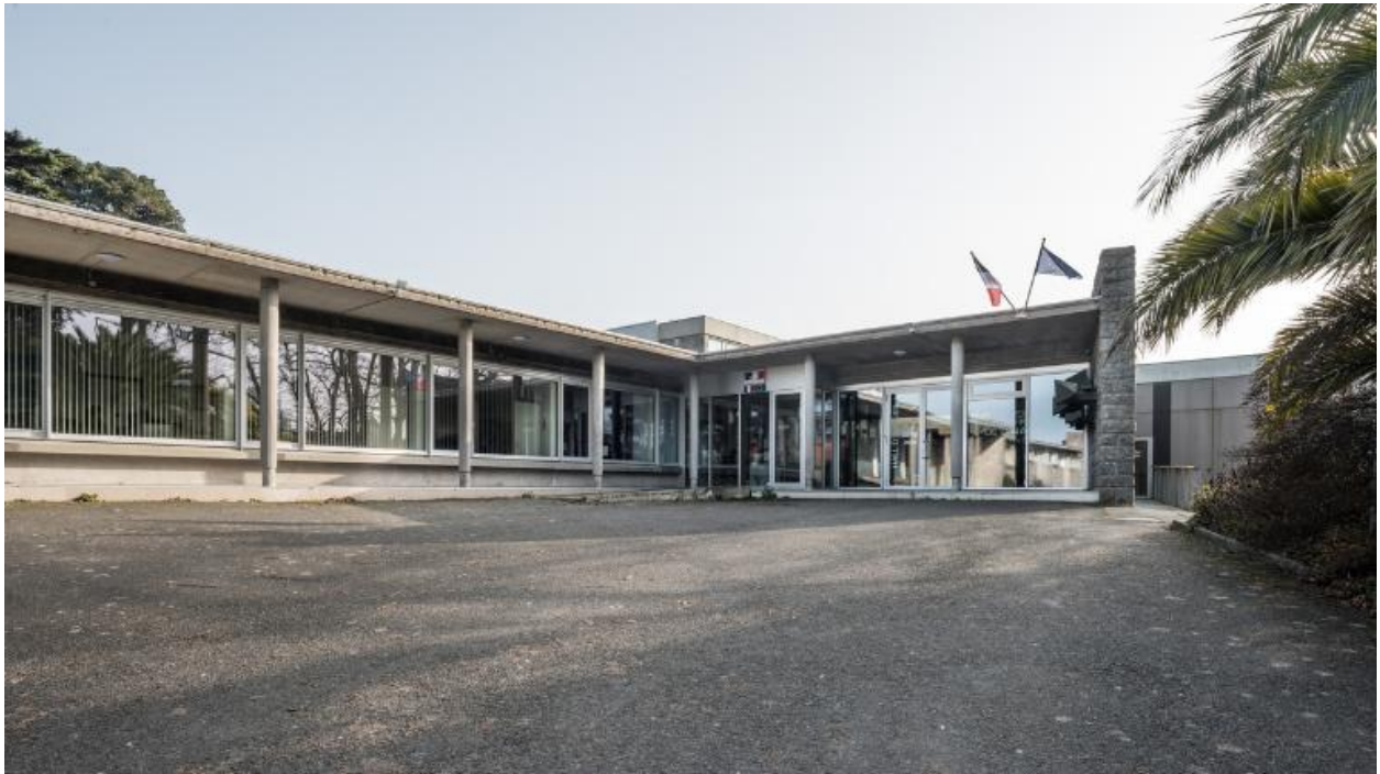
Façade ouest de l'administration et façade nord de l'accueil. Patrice Simon, architecte, 1973. On aperçoit, à droite, une partie de la sculpture de Georges Delahaie.
