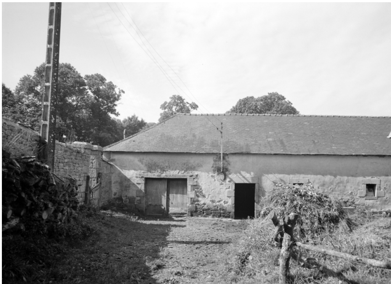
Communs, bâtiment central : face postérieure, partie gauche
