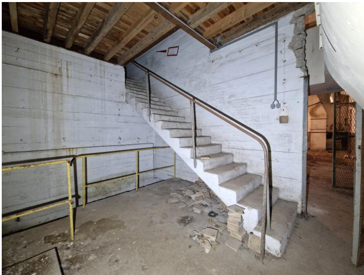
Locaux techniques, partie nord, rez-de-chaussée : cage d'escalier. Un escalier en béton armé dessert le sous-sol tandis qu'un second dessert les étages supérieurs
