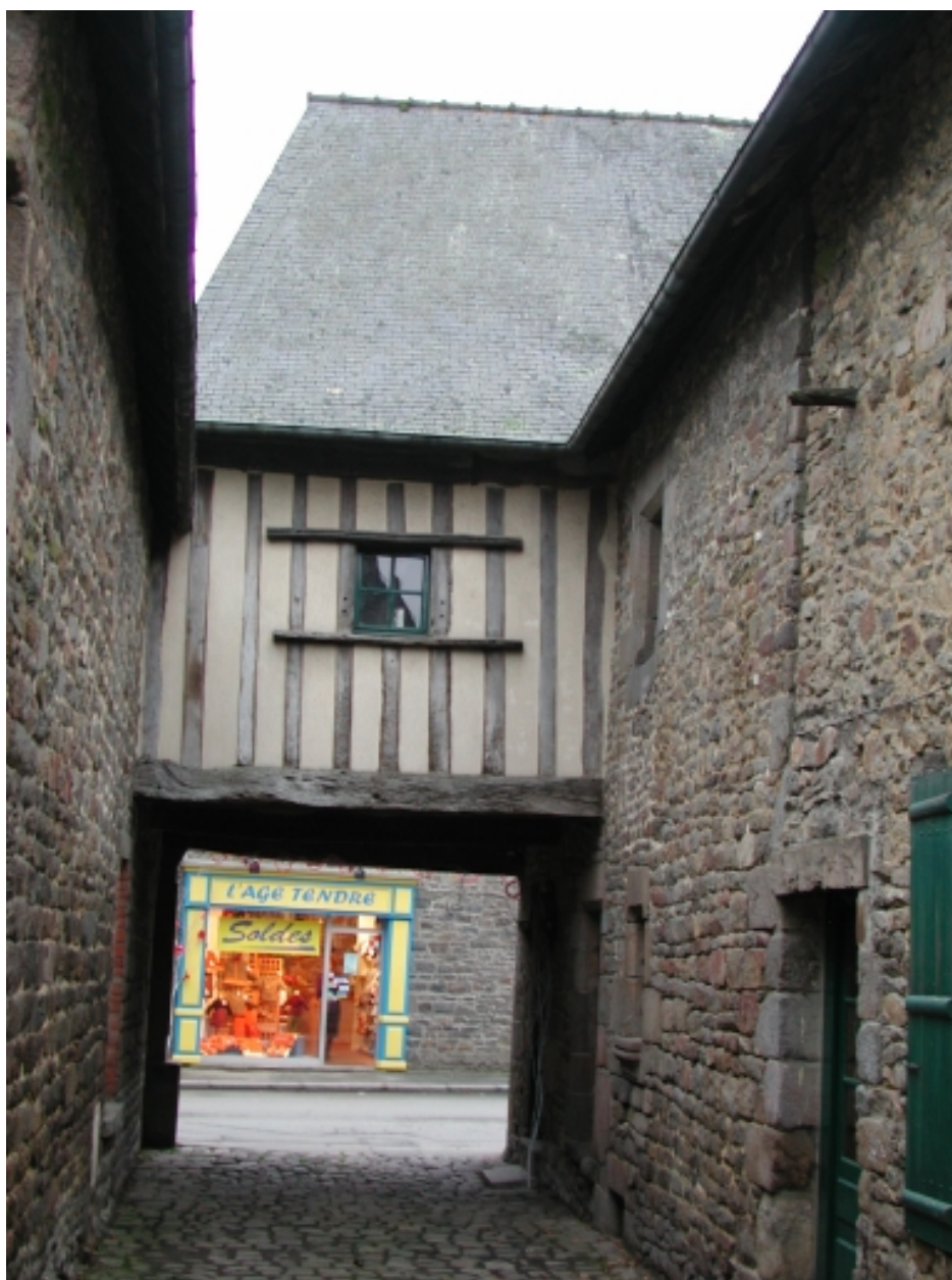
Vue partielle du mur Est et du passage couvert (2002).
