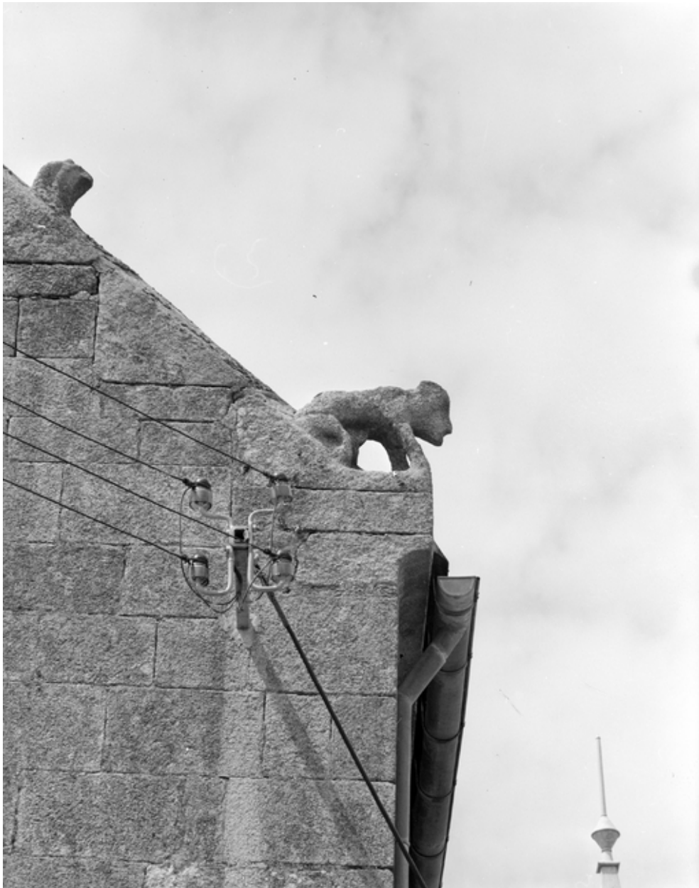
Plomodiern, église paroissiale Saint-Mahouarn : façade sud, pignon du transept, crossette droite, état en 1972
