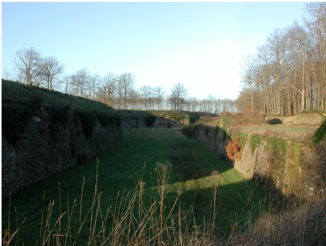
Vue du fossé sec Est
