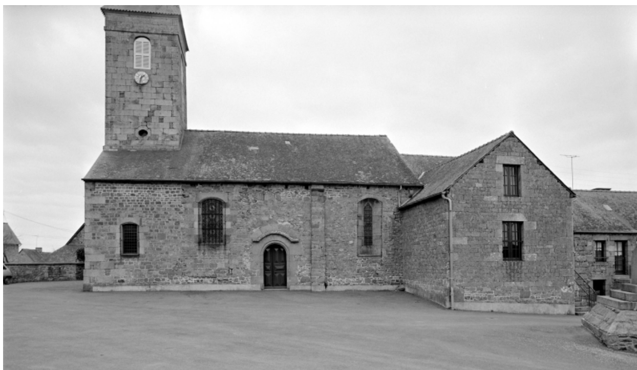
Elévation Sud, partie Ouest : vue générale
