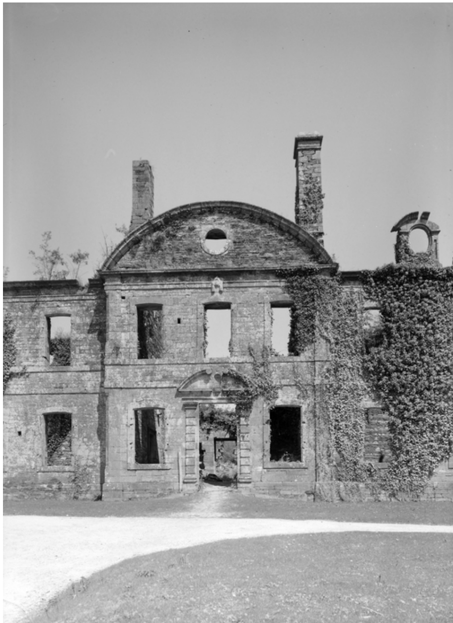
Logis abbatial, façade Ouest, détail : corps central (état en 1977).
