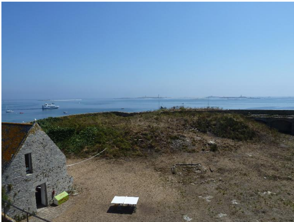
Archipel de Glénan, fort de l'île Cigogne, batterie Est, vue d'ensemble depuis l'ouest.
