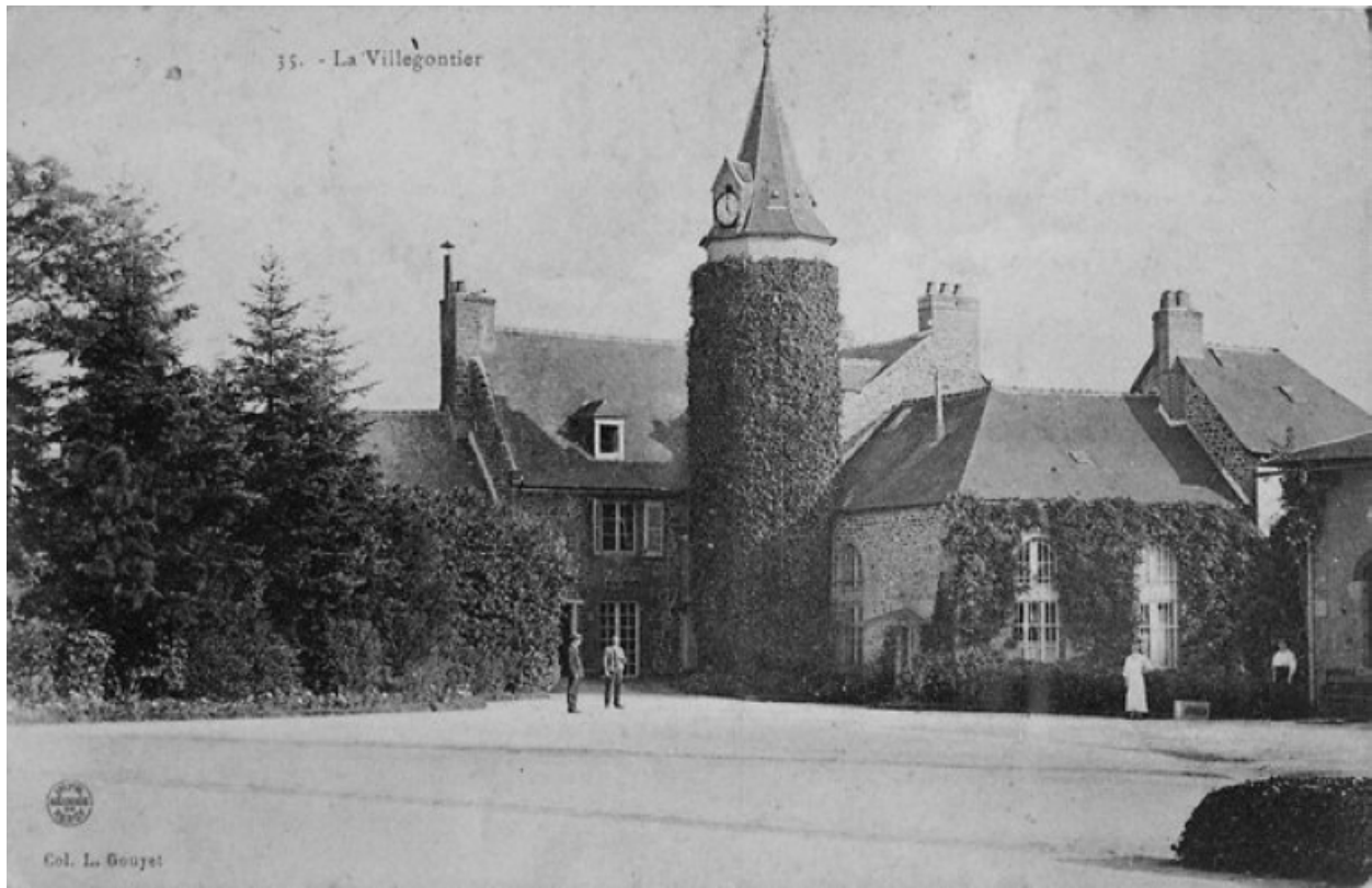
Vue sur l'arrière
