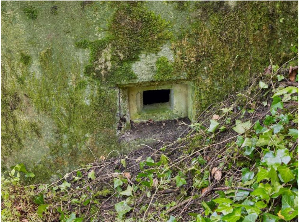
Vue de l'une des deux ouvertures de tir de la casemate de flanquement. Celle-ci a été modifiée pour en élargir le champ de vision et de tir. Ce type d'ouverture de tir était destinée à un fusil ou à une arme automatique
