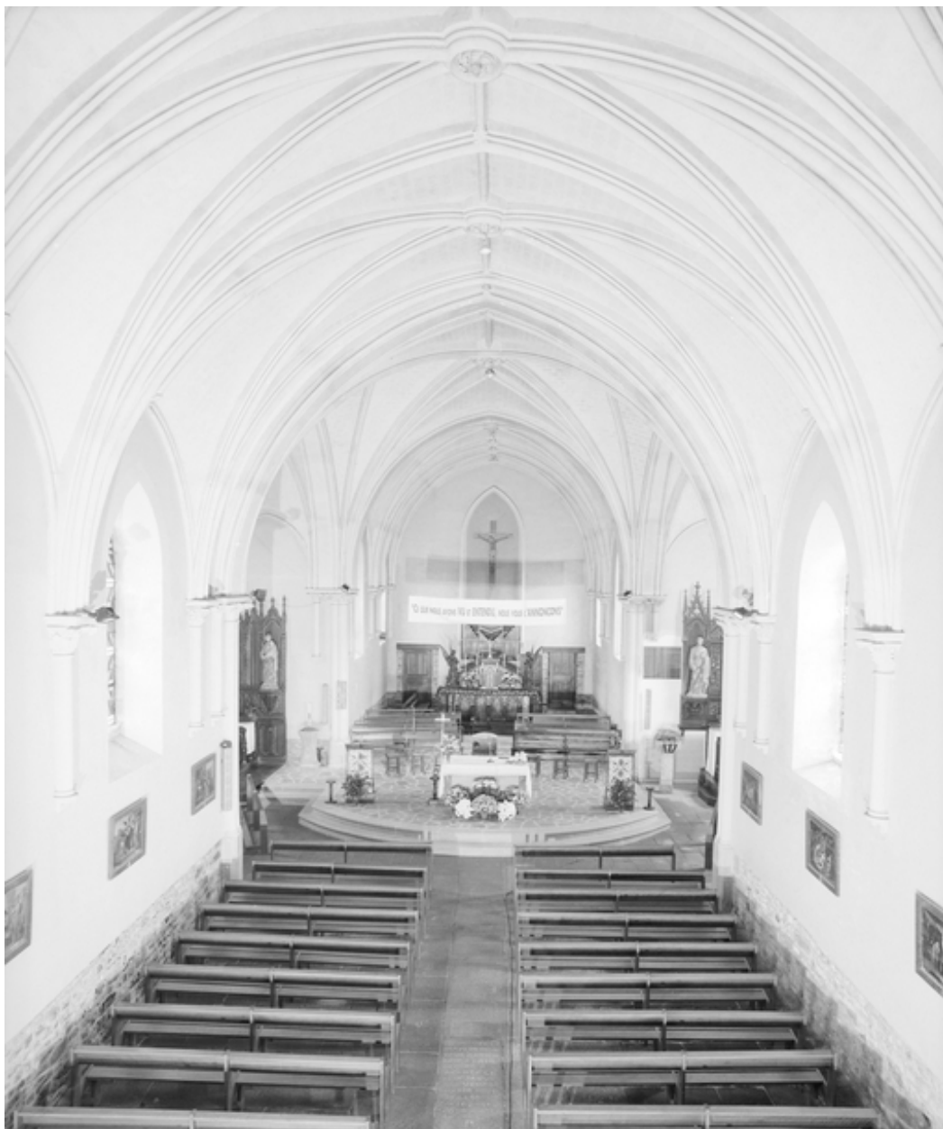
Intérieur : vue générale vers le chœur
