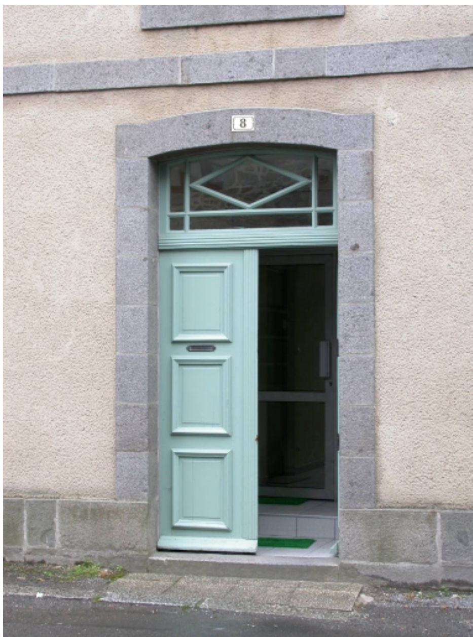
Détail de la porte d'entrée
