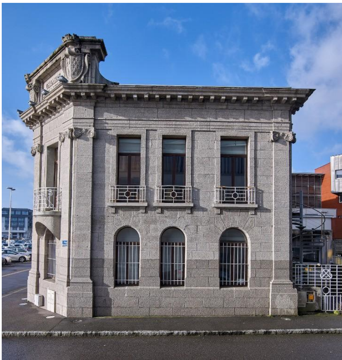
Chambre de commerce de Brest (1923)
