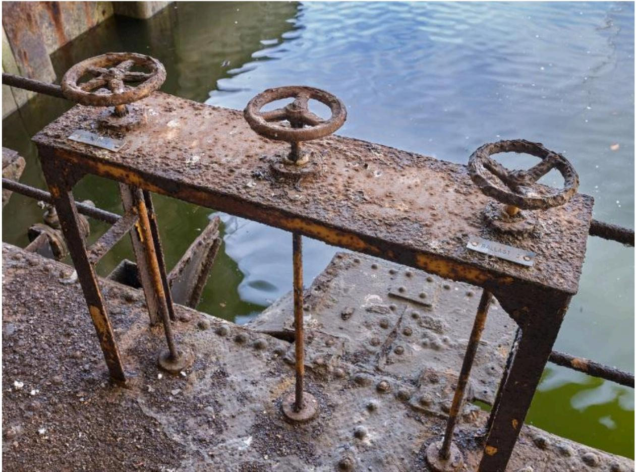
Vue des commandes des vannes du bateau-porte fermant le bassin (vers l'extérieur). On peut lire de gauche à droite : REMPLISSAGE 1, [plaque disparue, 2], BALLAST 3
