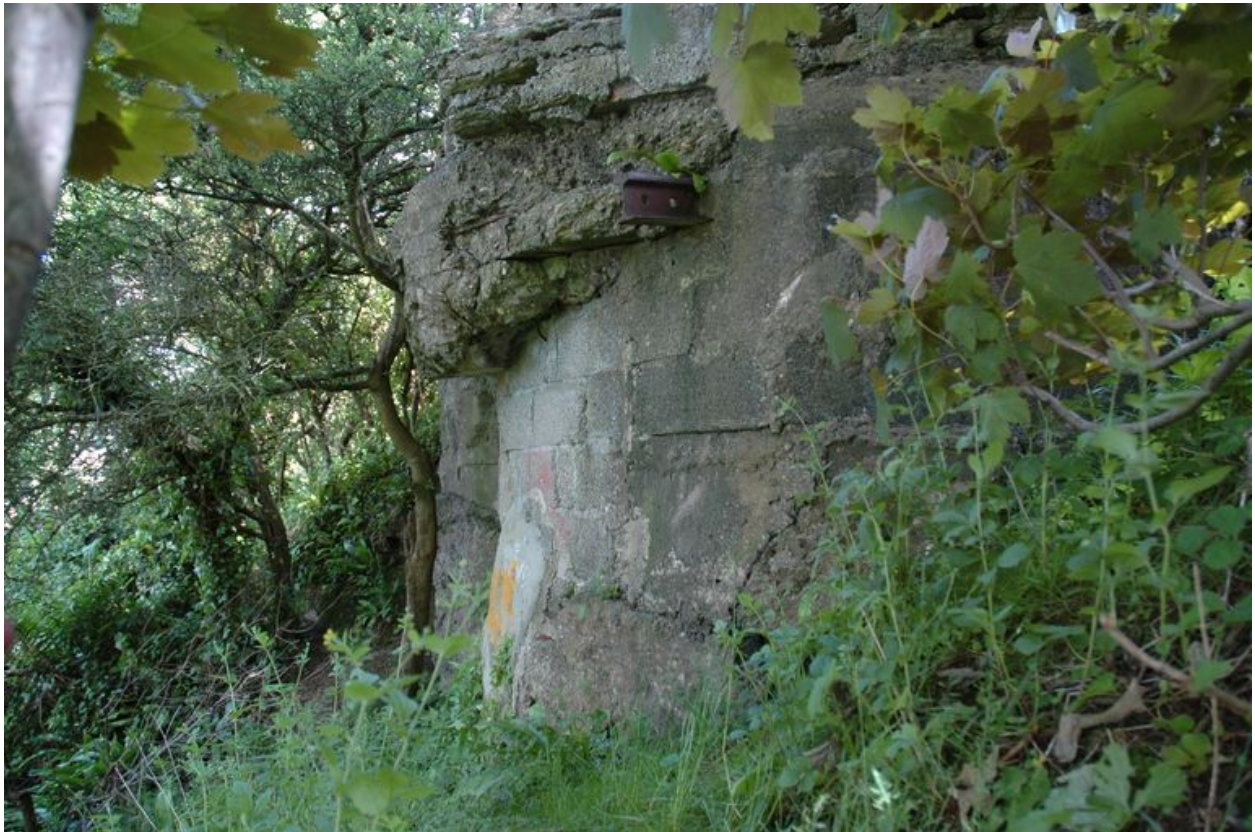
Vue des vestiges d'un bunker - casemate (poste d'observation d'artillerie ?) (état en 2007)
