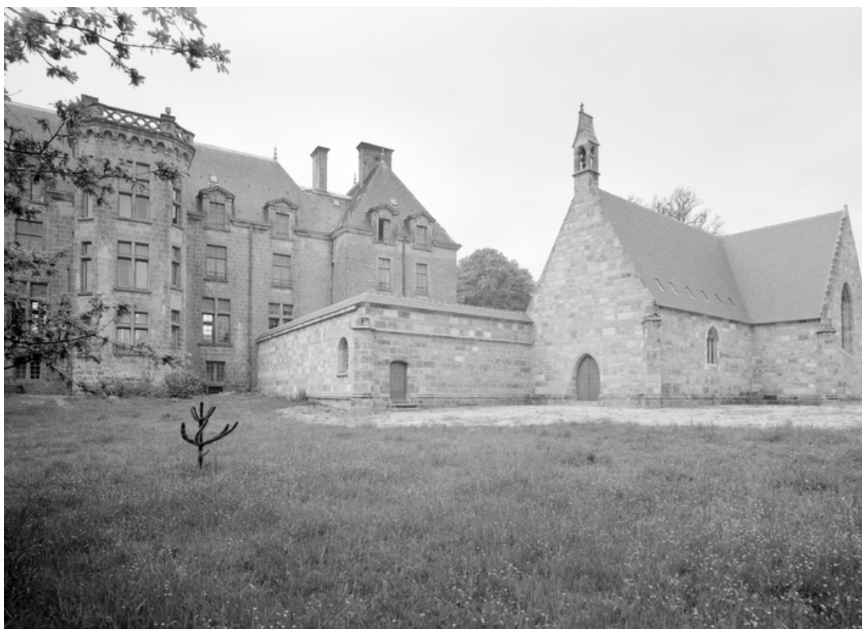
Chapelle du château - Vue générale, faces est et nord
