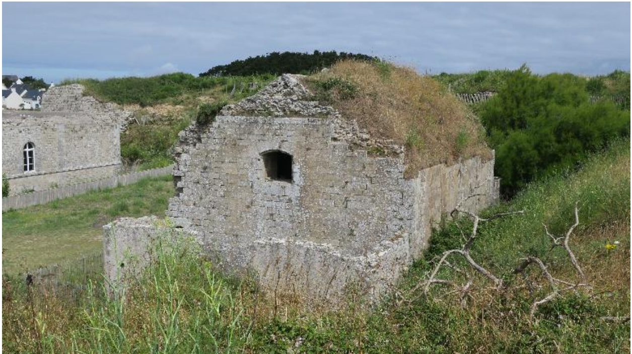
Hoedic, fort central, magasin à poudre, vue générale depuis le sud.
