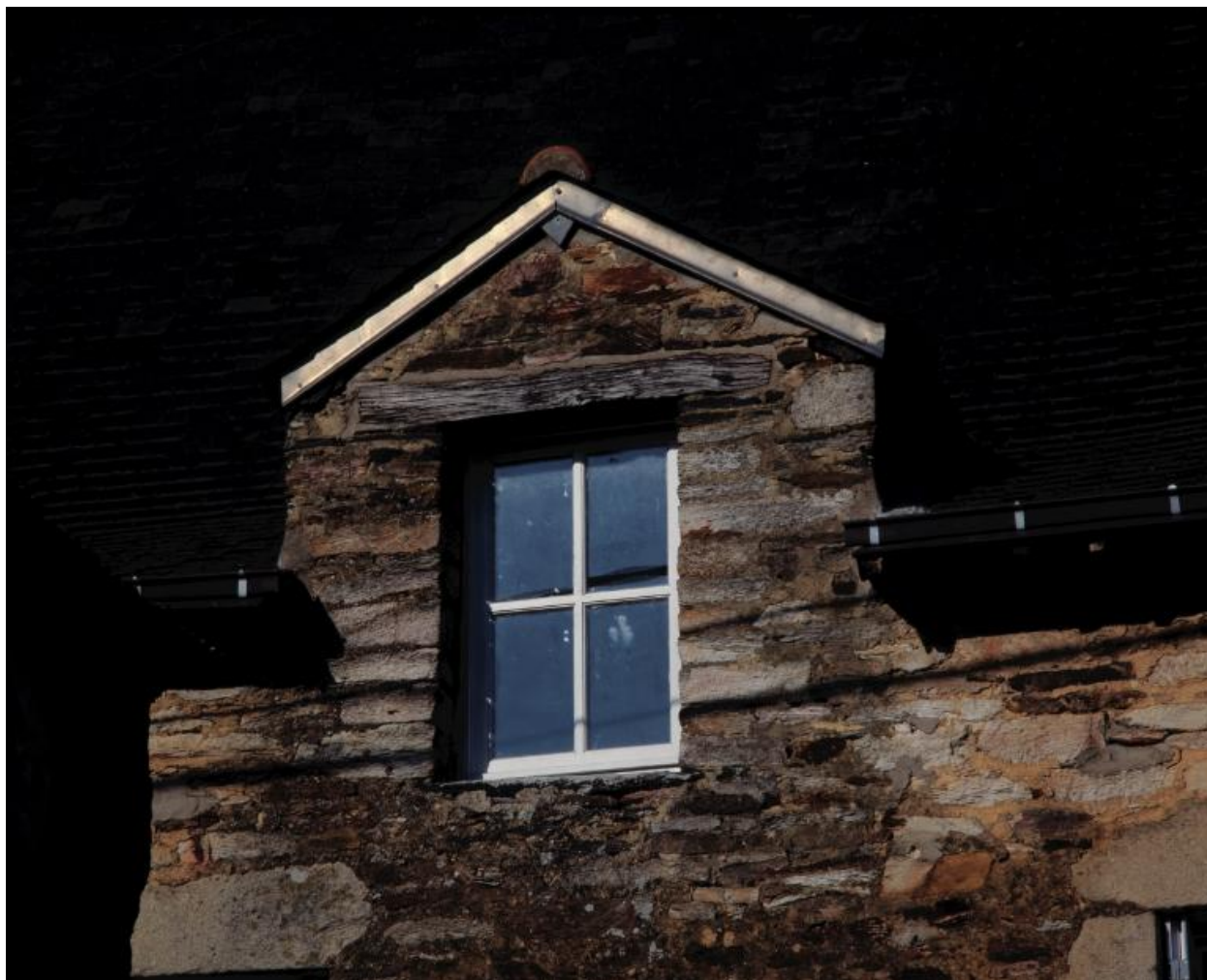
2, rue Basse, maison : la lucarne (état en 1988)
