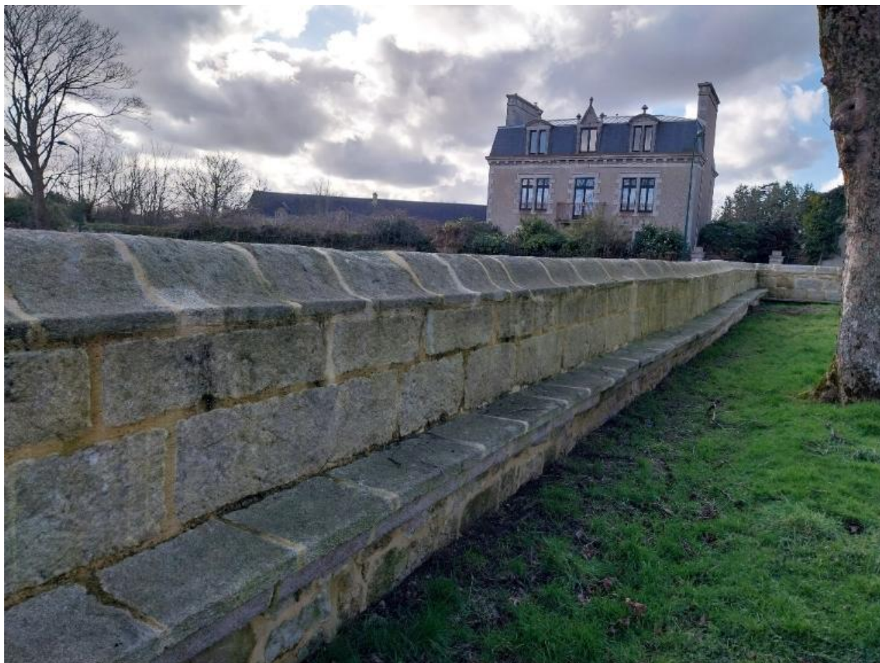
Mur de clôture avec banc en pierre
