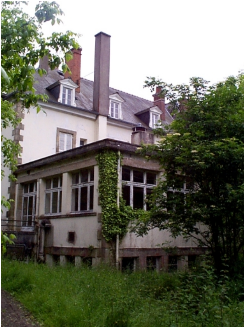
Détail : façade nord du château
