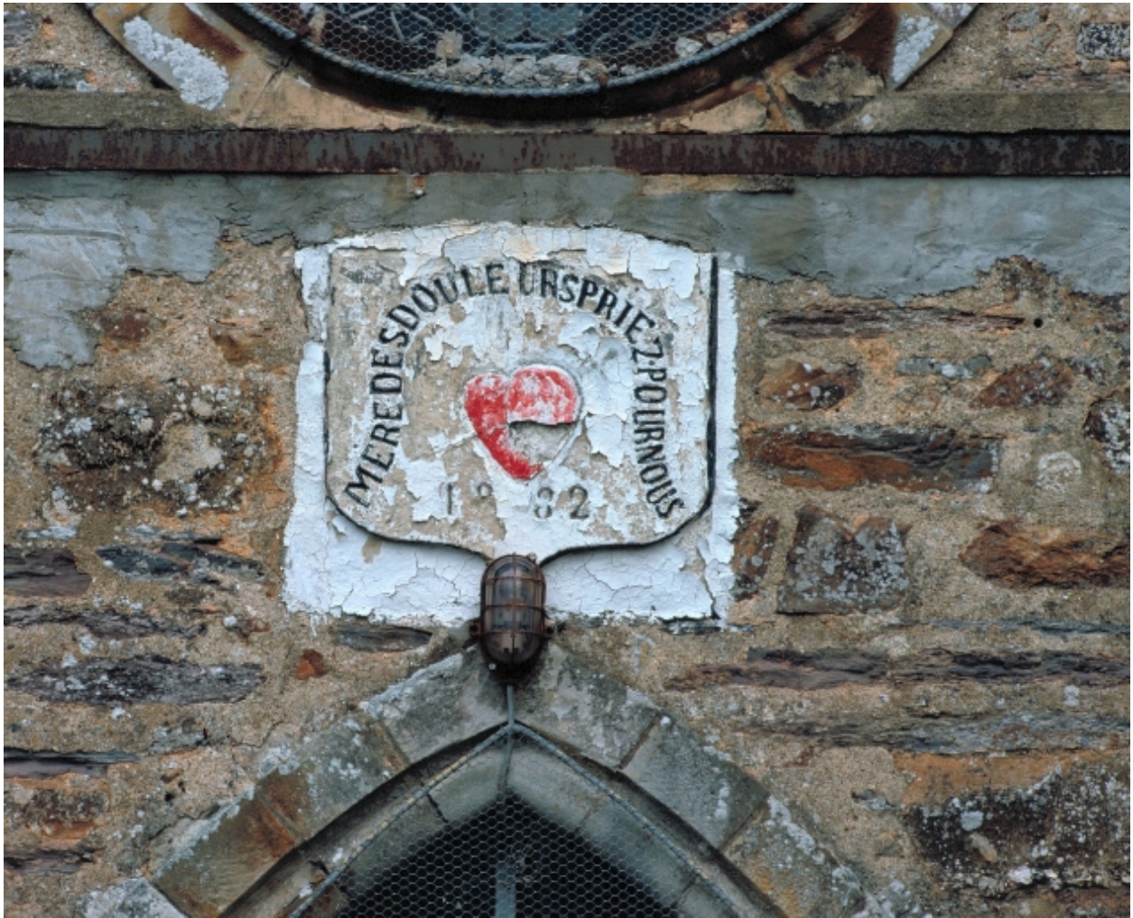
Façade sud, pierre de calcaire portant date et dédicace : détail
