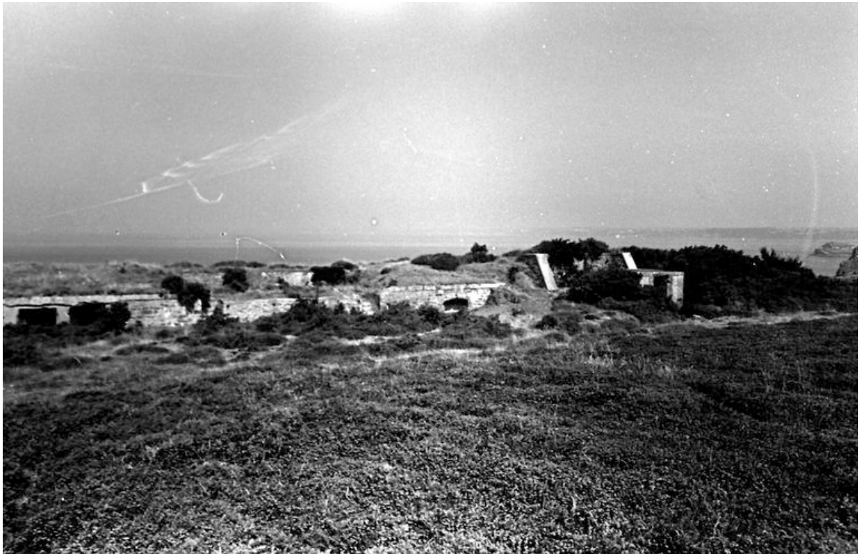
Vue générale de la batterie annexe de Tremet (état en 1969)
