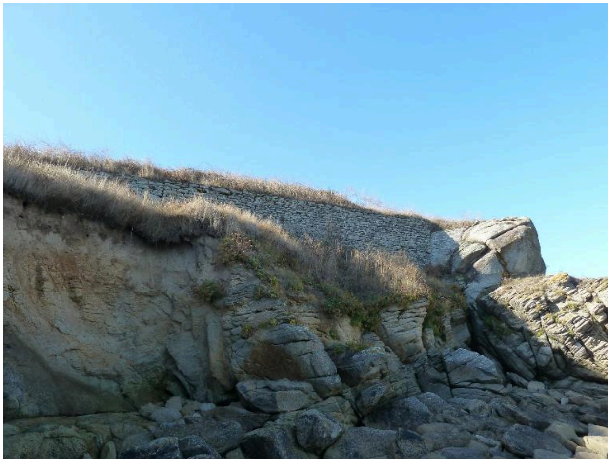
Quiberon, Fort Neuf, parapet côté mer.
