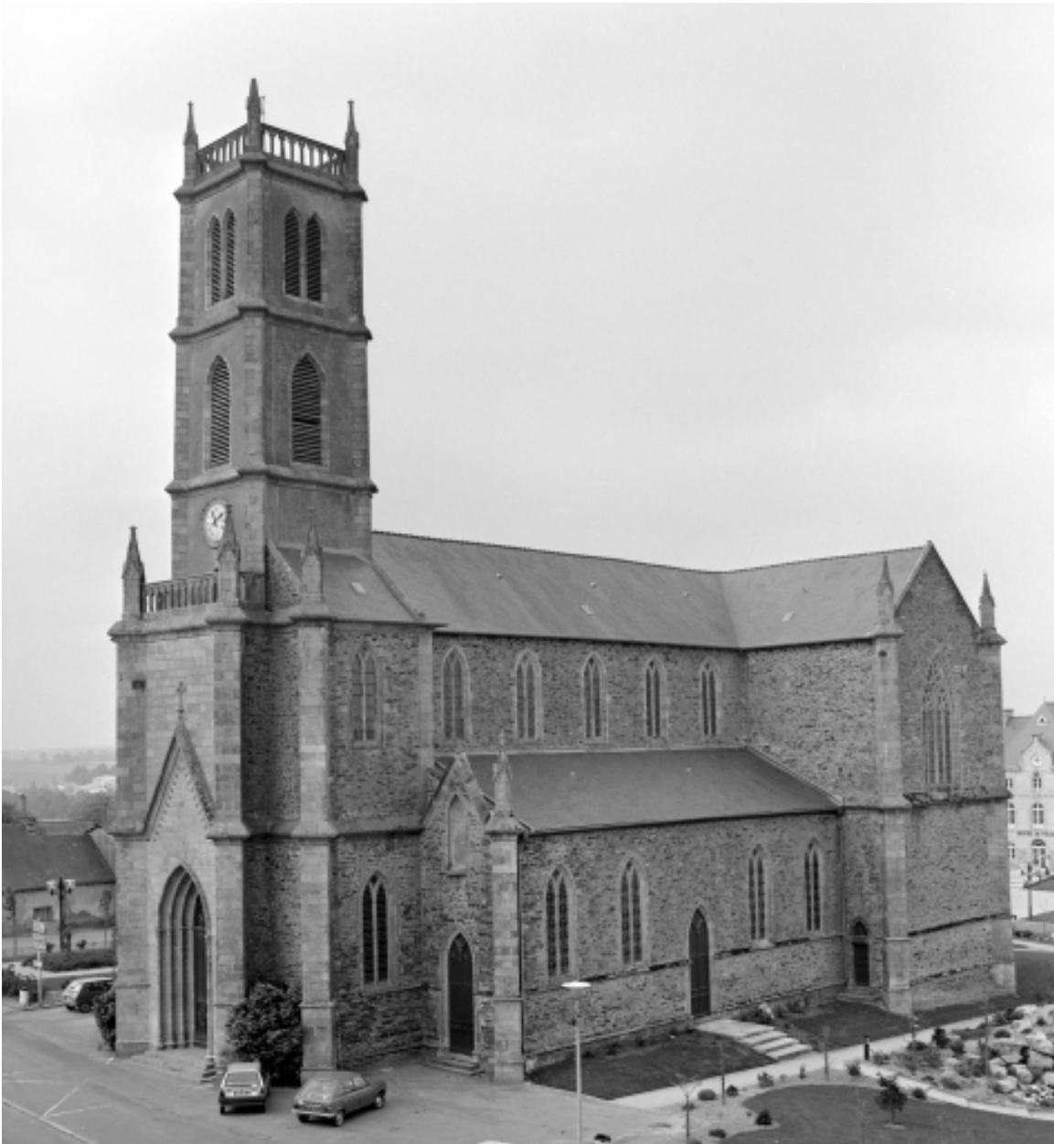
Elévation Sud-Ouest : vue générale
