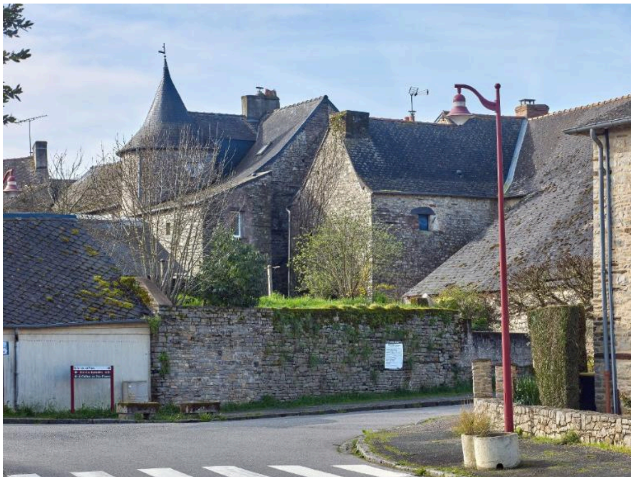
Vue de la tour à l'arrière du 8 rue de la Mairie
