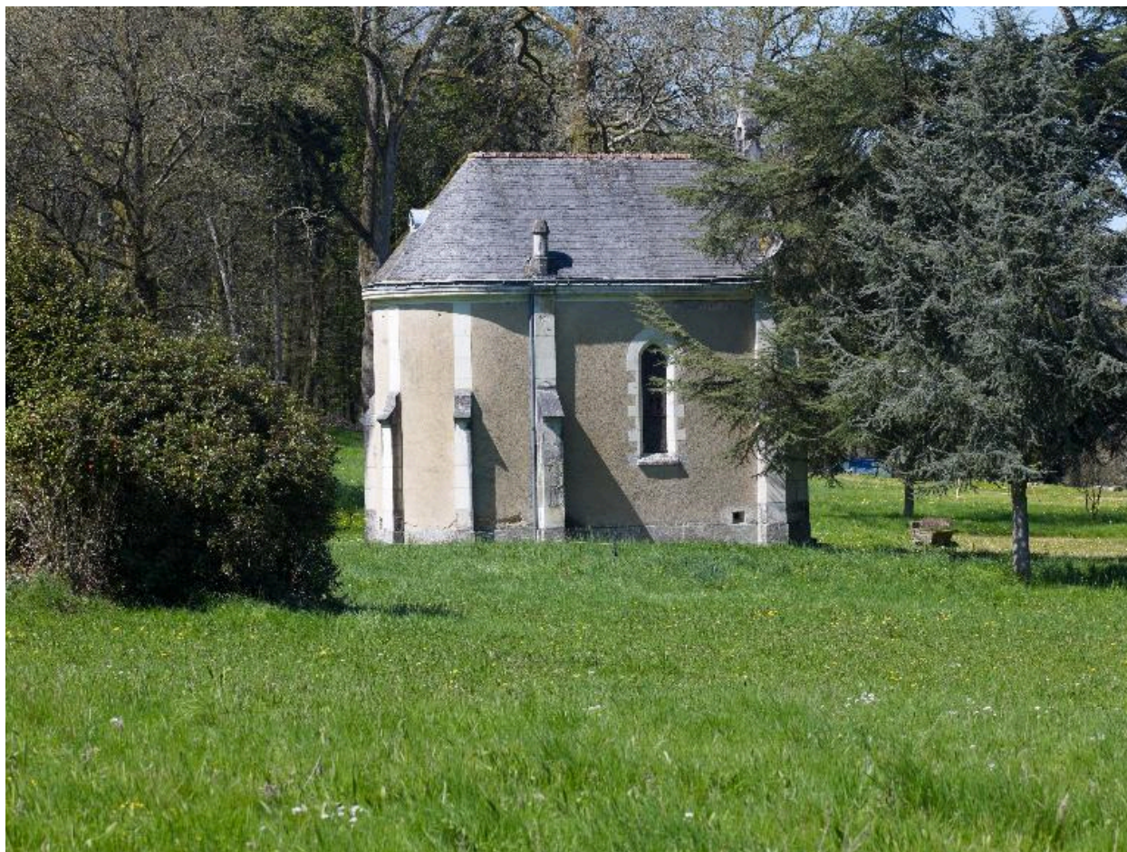
Façade est de la chapelle
