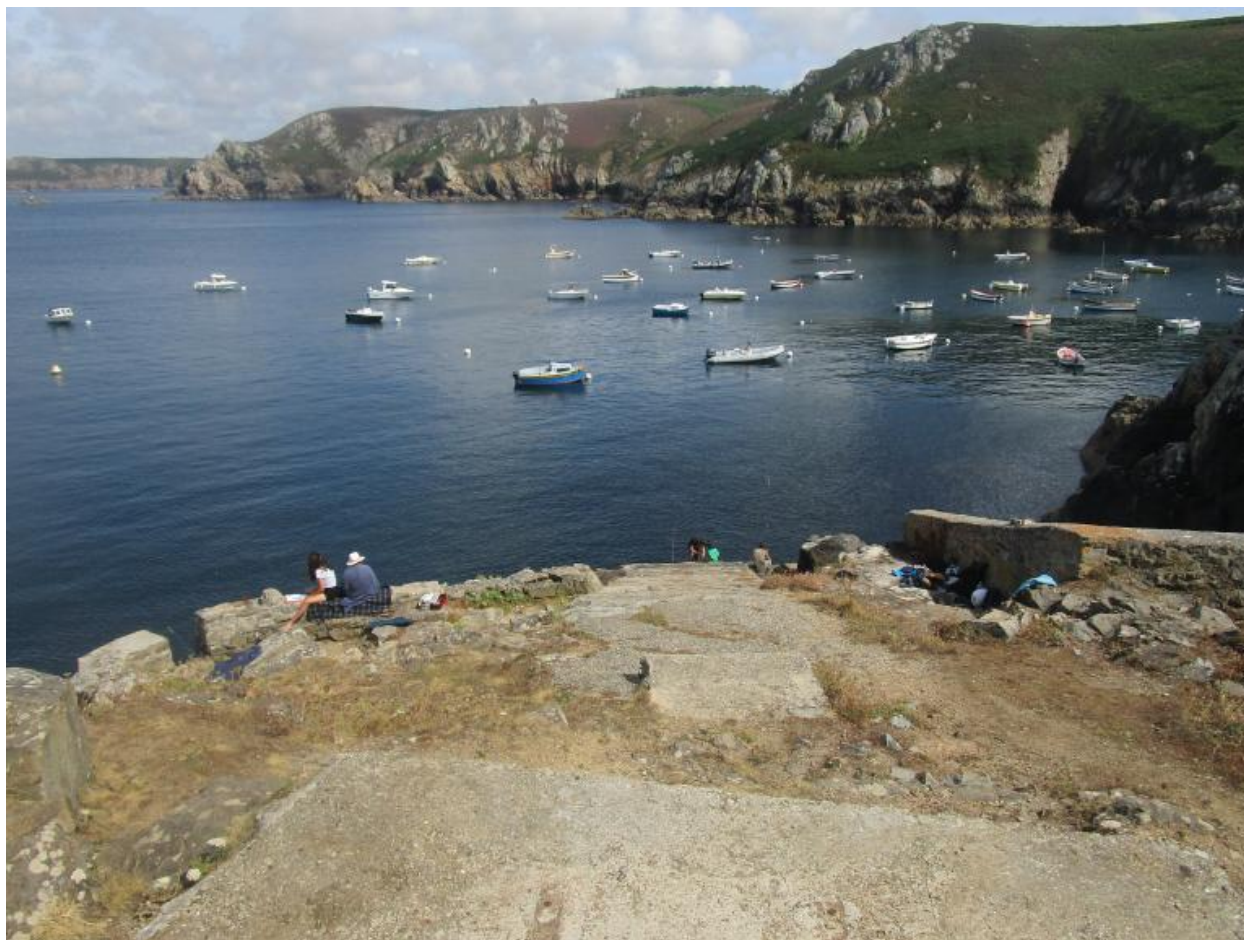
Cale de hissage nord, vue générale prise de l'ouest.
