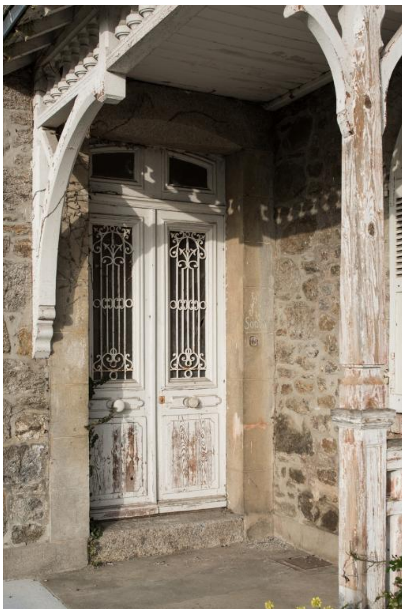
Porte d'entrée et porche.
