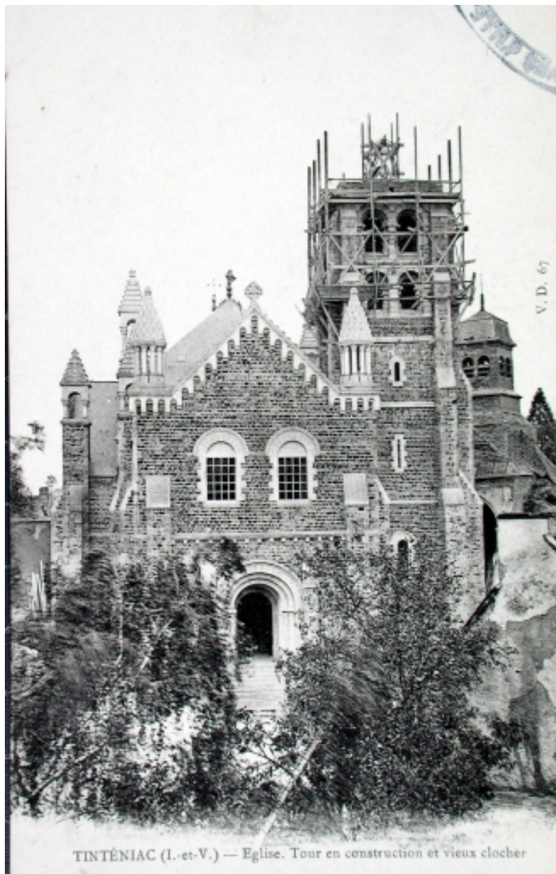
Construction de l'église paroissiale
